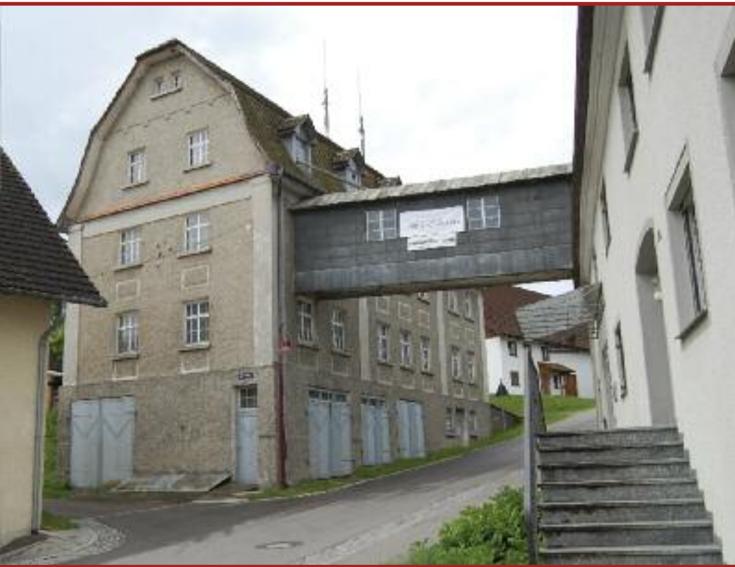
Das ursprünglich als Mühle geplante Lagerhaus von 1925.
